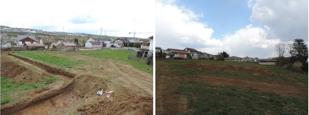
Abb.7: Knittlingen „Im Bergfeld“. Baggerarbeiten durch das PfP.
