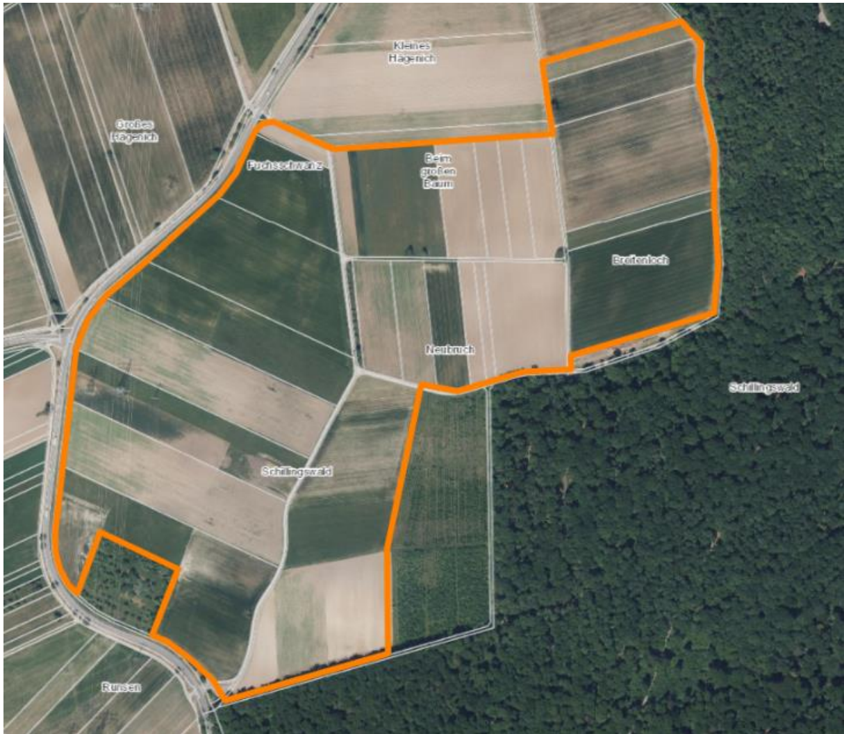
Abbildung 13: Luftbild Freiflächen-Photovoltaikanlage Schillingswald" (unmaßstäblich)
