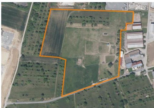
Abbildung 15: Luftbild "Freiflächen-Photovoltaikanlage Hellerhof" (unmaßstäblich)
